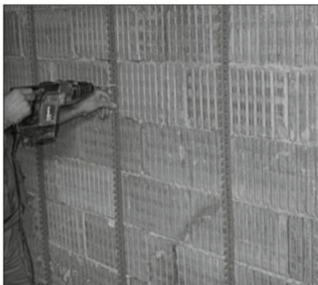
Posa dei binari su parete mediante tasselli
