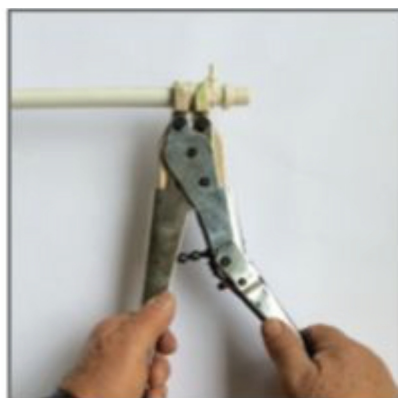
12. Quando la boccola giunge a fine corsa la giunzione è terminata
